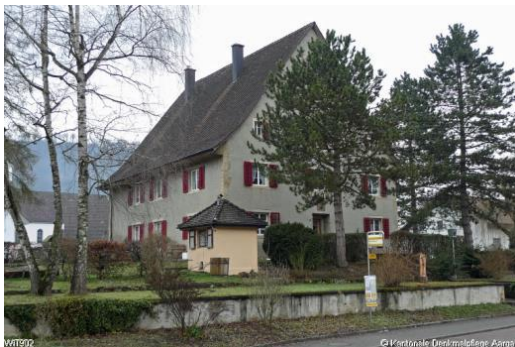
Pfarrhaus Wittnau. Quelle Bild: https://www.ag.ch/denkmalpflege/suche/detail.aspx?ID=112916
